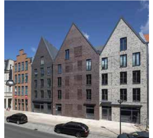
Üç Çatma Çatı Apartman, Anklam, 2022.
